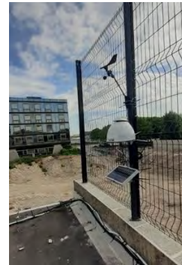
Figure 3 : Illustration du Kunak AIR Pro installé sur site
