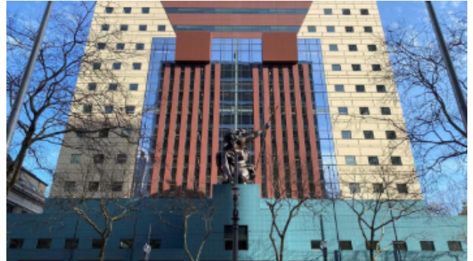
Bâtiment des services publics Portland, 1982
